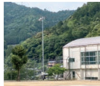
防災行政無線システム
