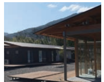
三好市人材循環促進施設
