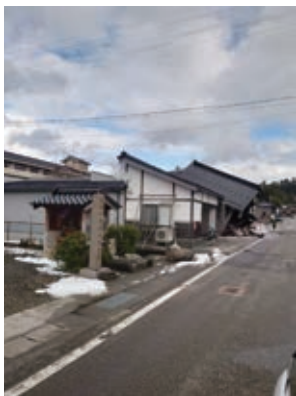
能登半島地震では、多くの家屋が倒壊した
