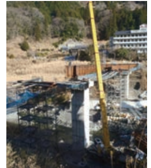
東祖谷（小川）に建設中の橋
