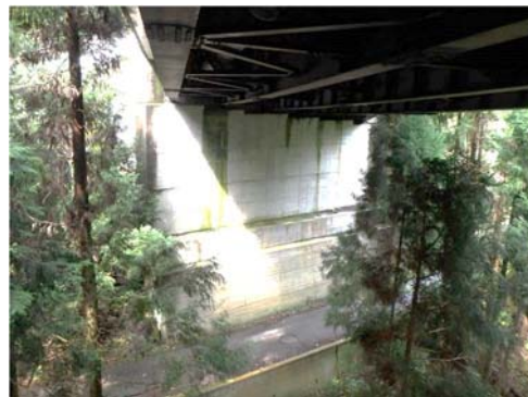
農道：宮ノ谷橋(跨道橋)
