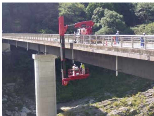
橋梁点検車による点検状況
