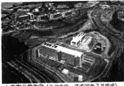
▲災害公営住宅（女川住宅 平成29年7月完成）
