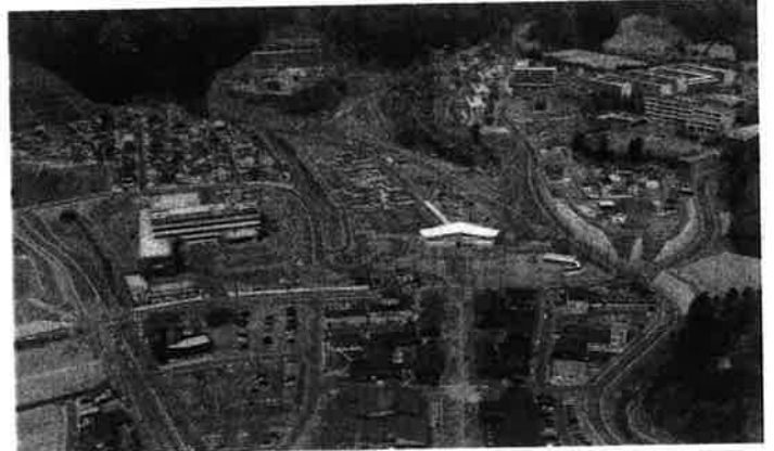
▲女川駅周辺の住宅 (左から、防集宅地(女川南区)、災害公営住宅(女川住宅、大原住宅、運動公園住宅)
