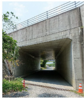
1.西側ボックスカルバート
