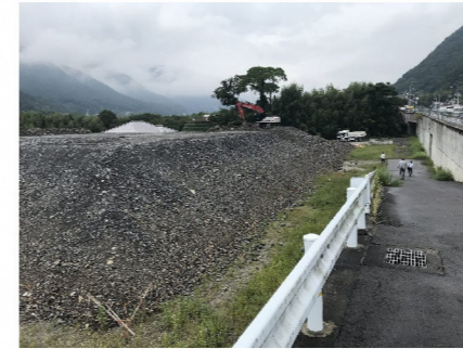
4.西方向を見る 盛土が搬入されている
