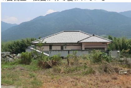
8.農業集落排水施設
