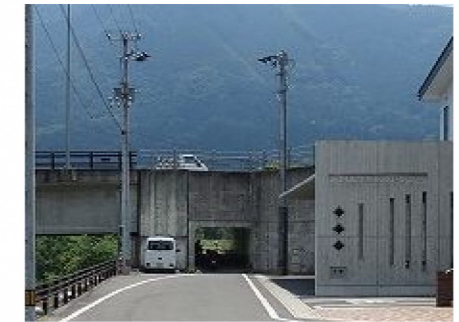
5.東側ボックスカルバート
