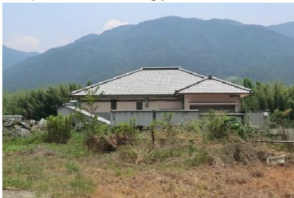
8.農業集落排水施設
