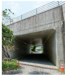
1.西側ボックスカルバート
