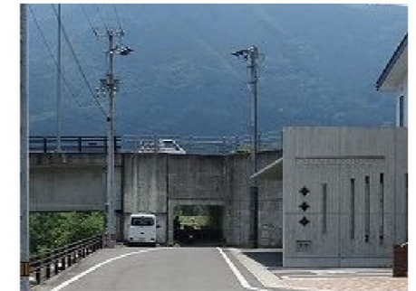
5.東側ボックスカルバート
