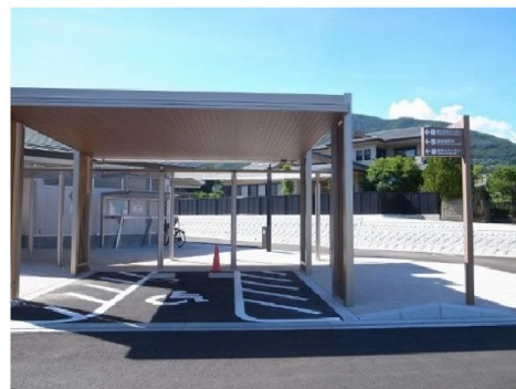
屋根のある身障者用駐車場 道の駅みまの里
