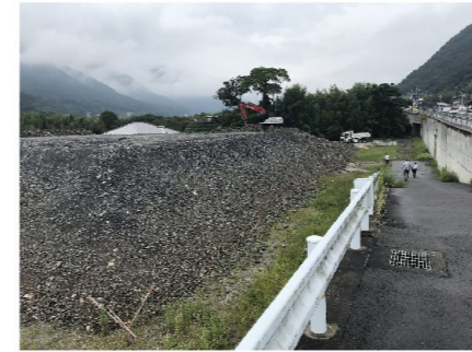
4.西方向を見る 盛土が撤入されている
