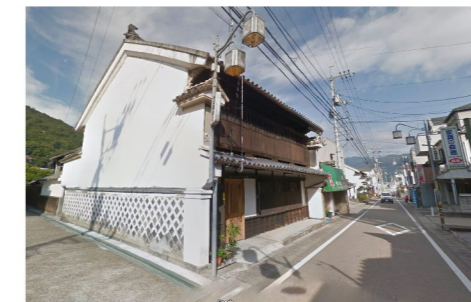
貞光のうだつ 2段の小屋根を付けた装飾的な「うだつ」が多く見受けられます
