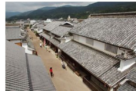
脇町のうだつ 妻側の袖壁を桁まで延ばさず小屋根を付けた形式の「うだつ」が多く見受けられます
