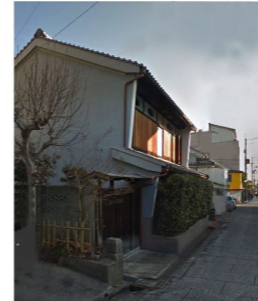
池田のうだつ 妻側の袖壁を桁まで延ばし、庇と一体にしたシンプルで実質的な「うだつ」が多く見受けられます
