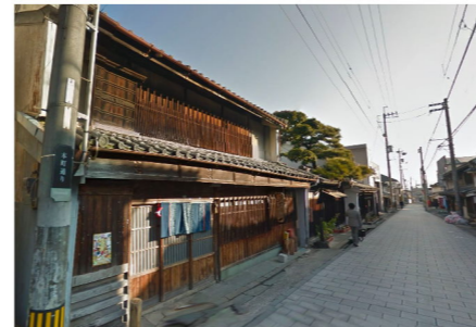
池田のうだつ 妻側の袖壁を桁まで延ばし、庇と一体にしたシンプルで実質的な「うだつ」が多く見受けられます
