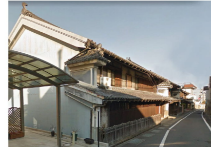
池田のうだつ 妻側の袖壁を桁まで延ばし、庇と一体にしたシンプルで実質的な「うだつ」が多く見受けられます
