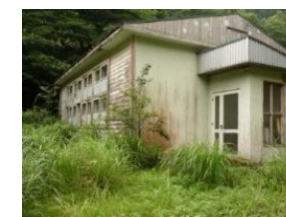
深淵集会所（東祖谷） 1974 年建築
