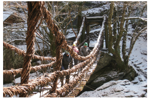
奥祖谷二重かずら橋架け替えの様子
