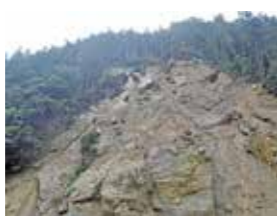
▲山腹崩壊箇所
