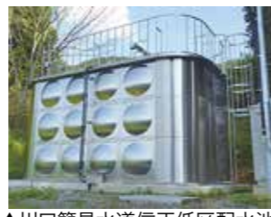
▲川口簡易水道信正低区配水池
