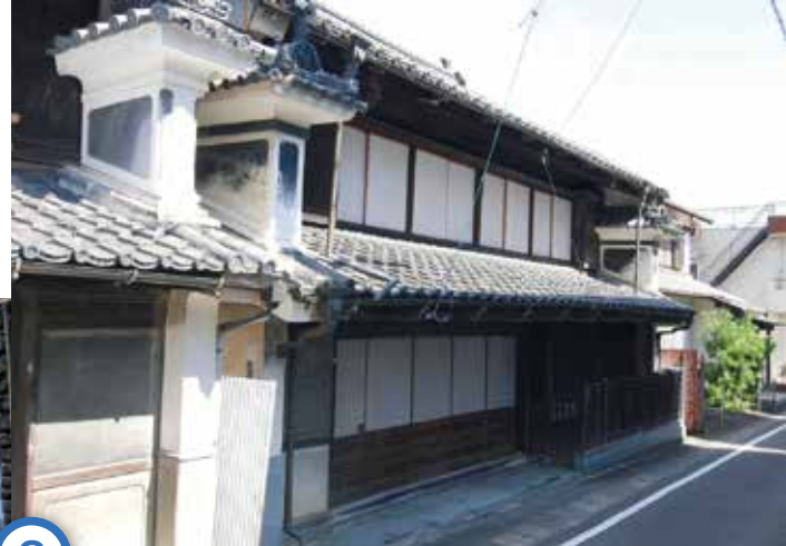
2 亀長家住宅主屋▲ 主屋は明治40年築。袖うだつを構える外観や、豪壮な根太天井など意匠を凝らしている。
