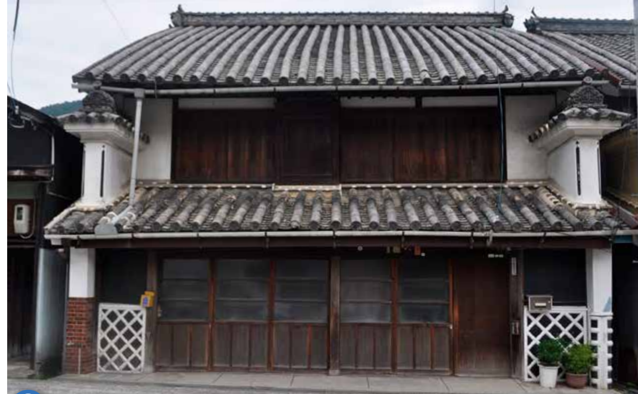
4 ▲佐藤家住宅主屋 本瓦葺の池田の町家。なまこ壁を取り入れている。
