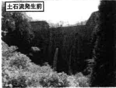
梨子沢砂防堰堤の状況
