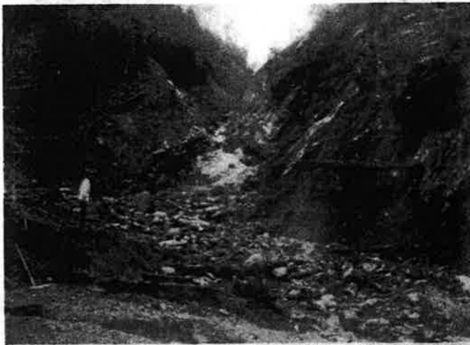
重里の山崩れ(旧西十津川村)
