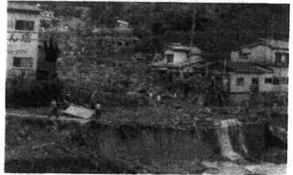
地区で最悪の37名の犠牲者 川平地区の土石流災害(浦上川水系)
