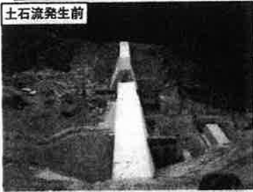
梨子沢第2砂防堰堤の状況
