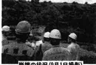
崩壊の状況(9月1日撮影)
