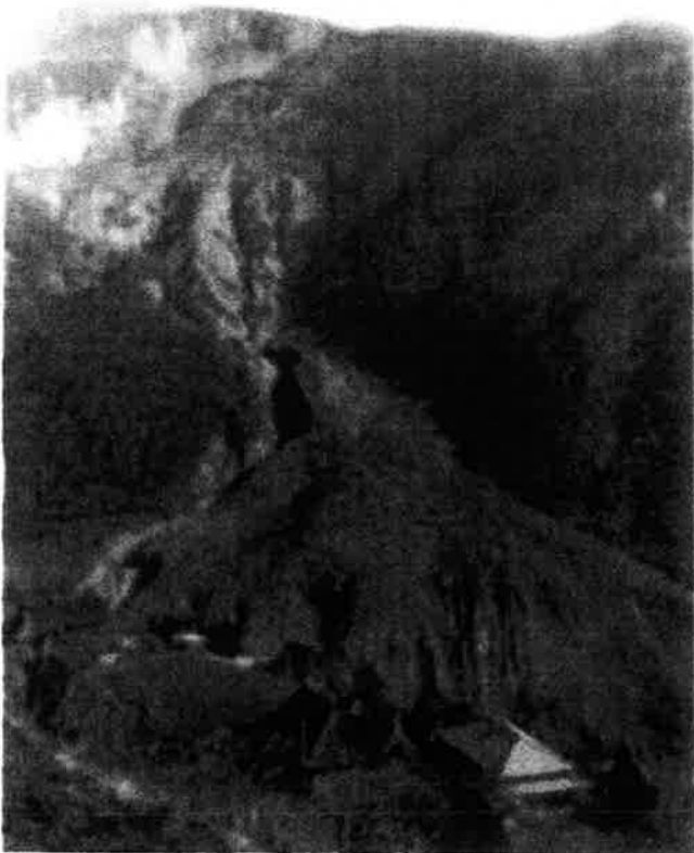
足柄上郡山北町玄倉地内（向沢） 1927年3月撮影
