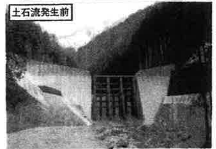
梨子沢第1砂防堰堤の状況
