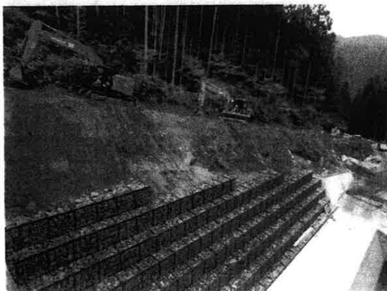
管内整備工事施工中 (上松町、大桑村、南木曾町)
