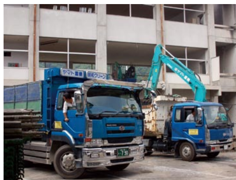
新校舎の建築に向け、解体工事が開始された池田中学校
