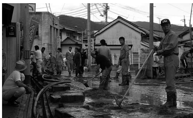
平成16年台風21号と23号で土砂災害の被害を受けた井川町辻地区
