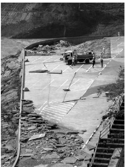
平成16年台風16号で冠水被害を受けた河川敷駐車場(山城町)
