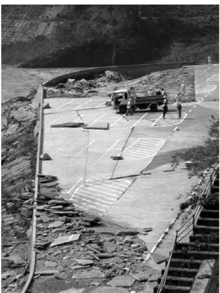
平成16年台風16号で冠水被害を受けた河川敷駐車場(山城町)
