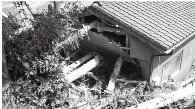
平成16年台風21・23号による土砂災害 野呂内地区（写真上） 辻地区（写真下）
