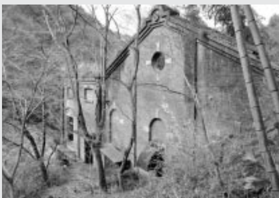
旧三縄発電所
