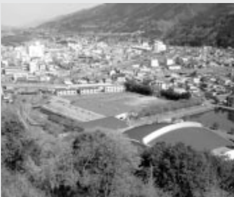
交流拠点施設建設用地全景
