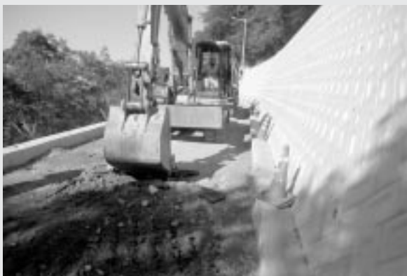
公共工事現場
