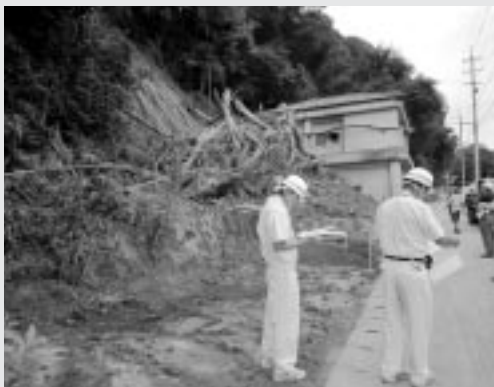
池田町内の災害現場
