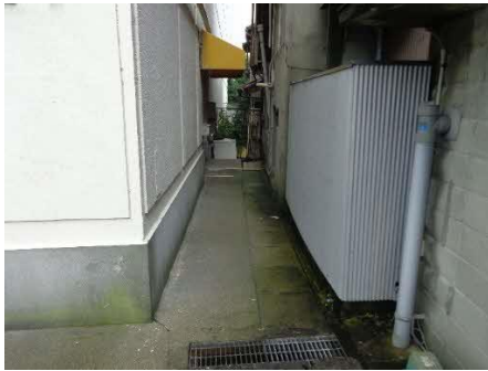
写真1 施設南側の宅地との境界
