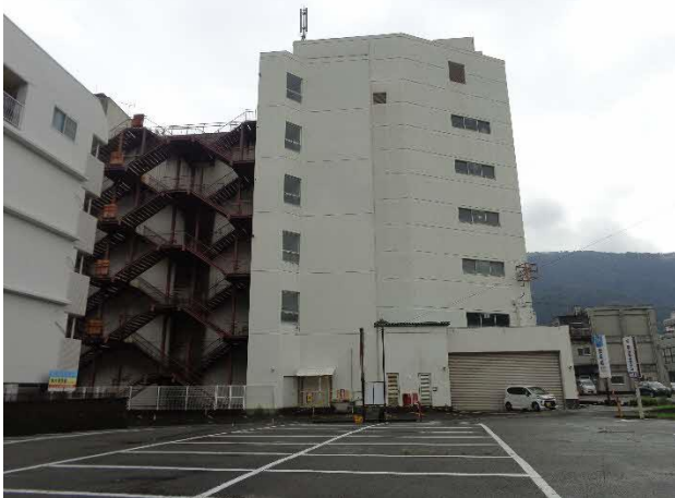
写真1 施設外観（北側旧駐車場より）
