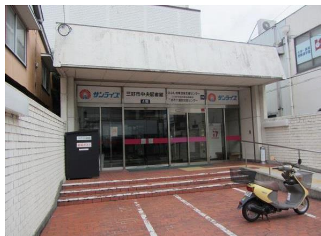
写真4 施設外観（南側旧出入口）
