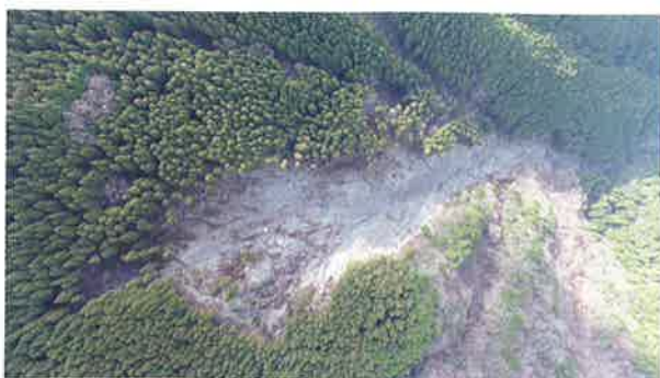
野鹿池地区 (国直轄治山) ※空撮
