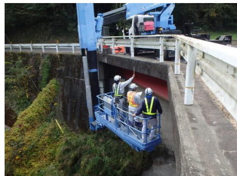
橋梁点検車による点検状況
