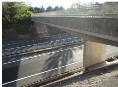
西ノ原橋(高速道路)
