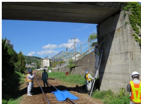
梯子による点検状況
