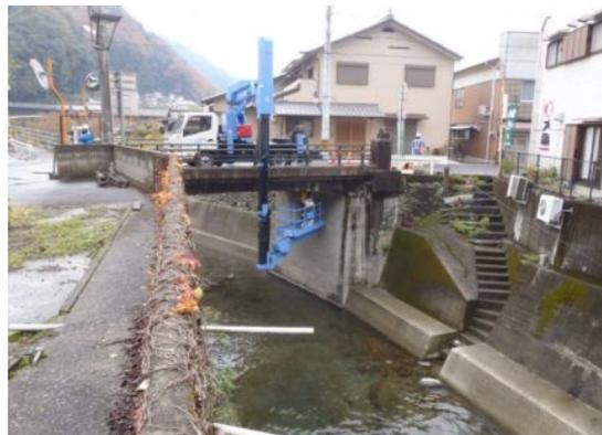
橋梁点検車による点検作業
