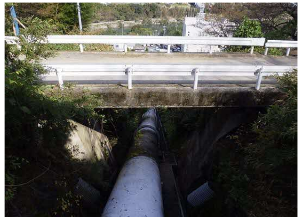
片山第1橋(四国電力・水圧管路)
