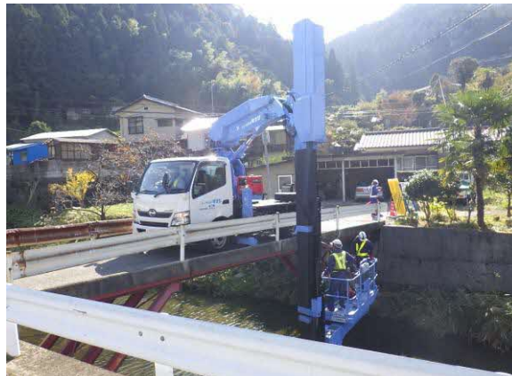
橋梁点検車による点検作業
