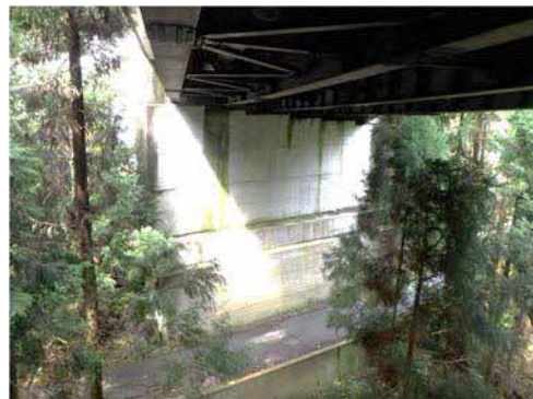
農道：宮ノ谷橋(跨道橋)
