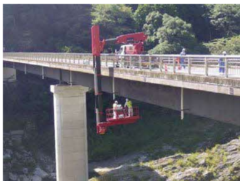
橋梁点検車による点検状況
