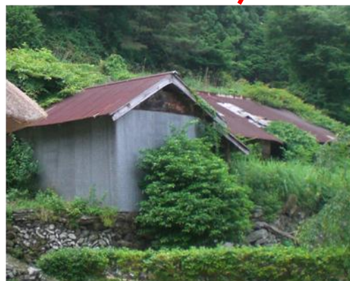
■景観を阻害している隣接の廃屋
