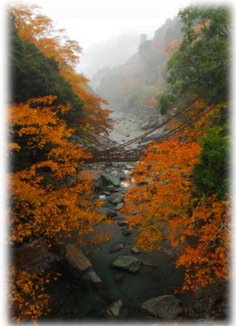
■重要有形民俗文化財 祖谷の蔓橋 伝統的な架け替え作業により守られている
