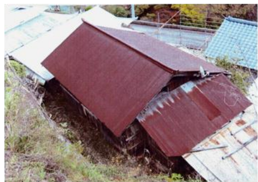
②隠居棟の保存修理
