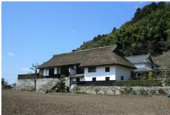
■川人家長屋門
