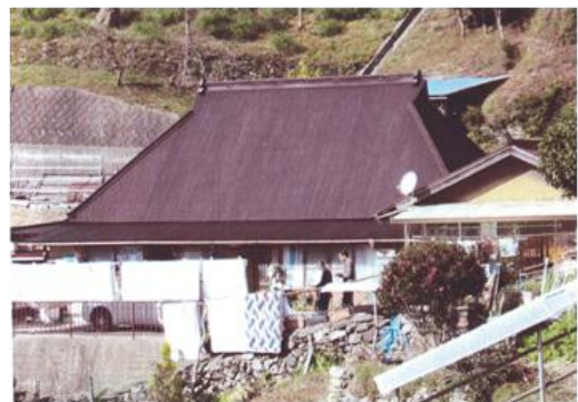
①主屋の保存修理
