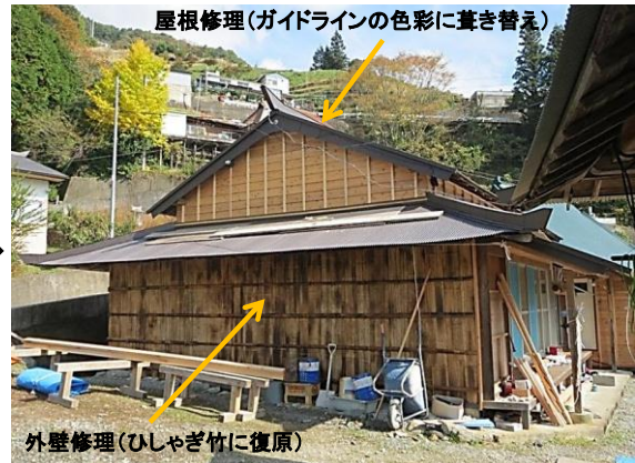
柿平家主屋保存修理(完成)
