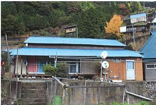
柿平家主屋保存修理(施工前)
