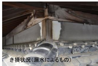
き損状況(漏水によるもの)
