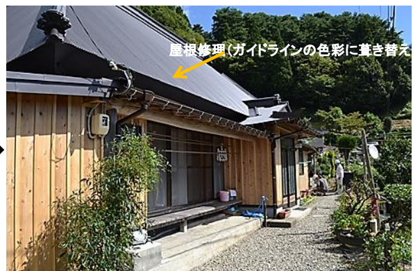
長岡家主屋保存修理(完成)
