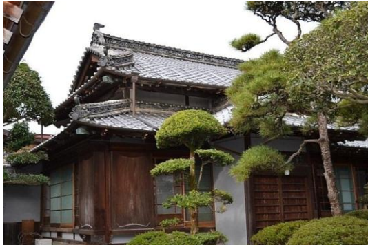
離れ座敷保存修理(施工前)
