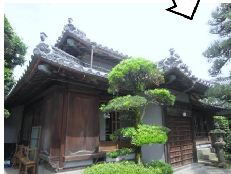
離れ座敷保存修理(完了)
