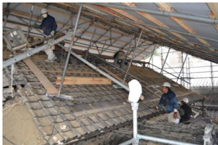
離れ座敷保存修理(施工中)
