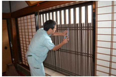
建物の詳細調査状況
