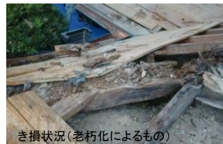
き損状況(老朽化によるもの)
