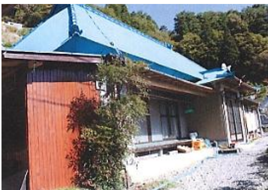
長岡家主屋保存修理(施工前)
