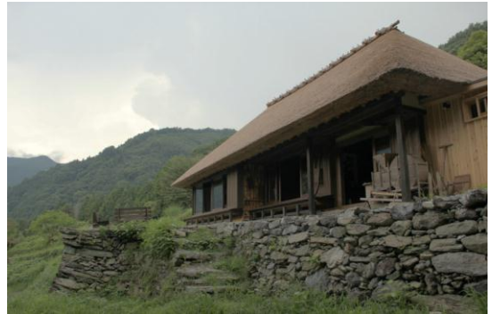
保存修理が完了した簾庵住宅(平成24年度)
