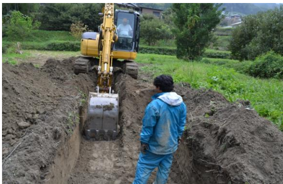
埋蔵文化財試掘調査の状況 (H24. 6. 23 井川町佃地区)
