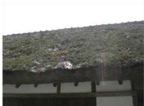
■平成5年に葺き替えされたが、現在では老朽化で屋根部の傷みがひどい
