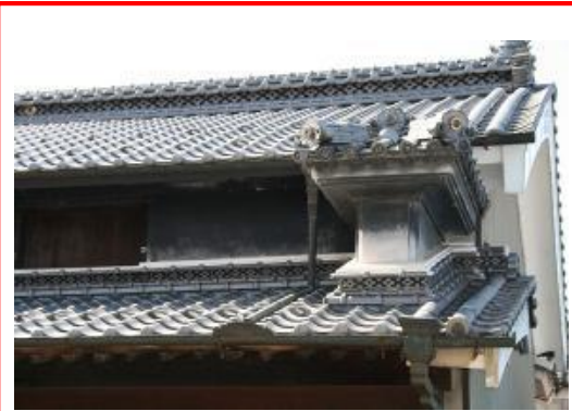
■辻町のうだつのある伝統的な町屋
