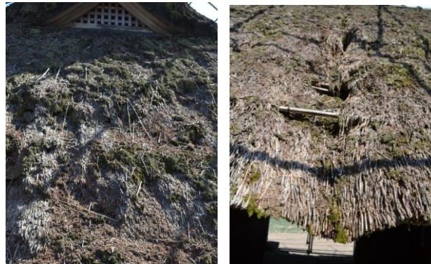
■屋根部の 破損状況
