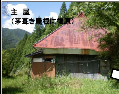
特定物件の空き家「曾我家」施工前
