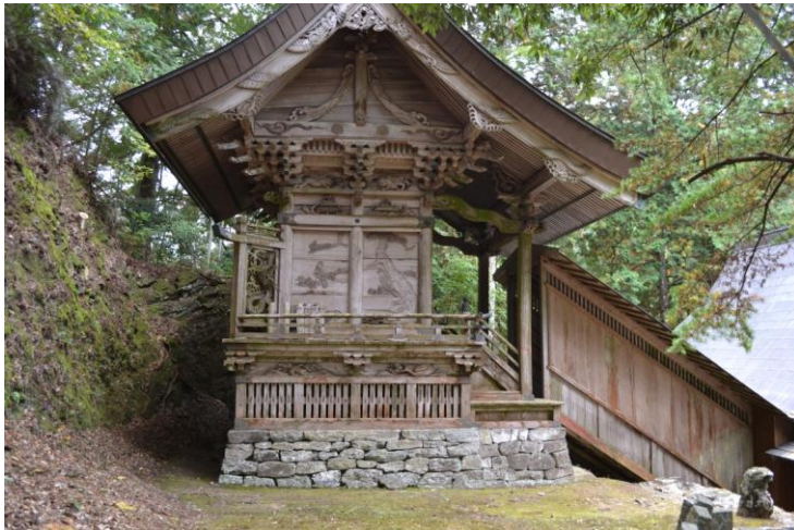
詳細調査を行った未指定建造物(大日雲神社)
