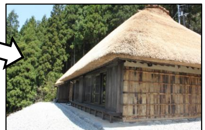
「曾我家」施工後(完了)
