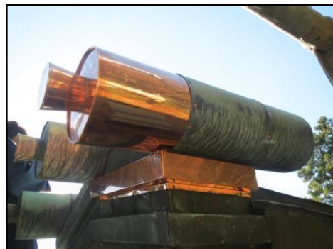
重要文化財箬蔵寺本殿奥殿大棟修理 (本殿裏山からの倒木により、奥殿大棟鬼部が一部き損したため、小修理を実施した)
