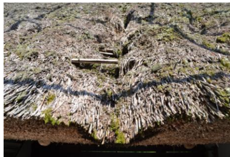
■屋根部の 破損状況
