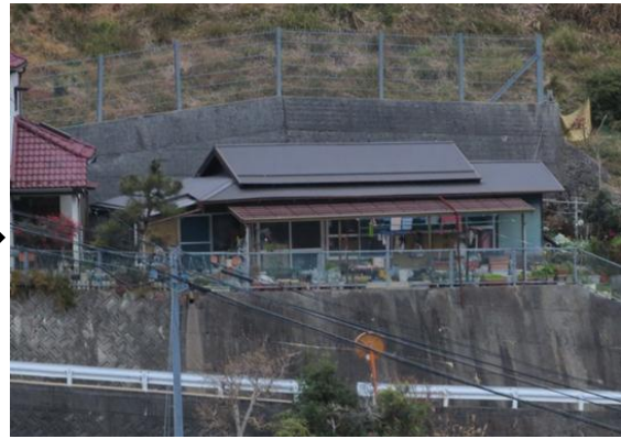
屋根塗り替え後(完了)
