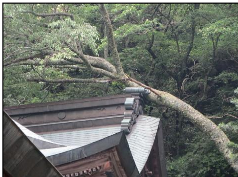
重要文化財箬蔵寺本殿奥殿大棟修理 (本殿裏山からの倒木により、奥殿大棟鬼部が一部き損したため、小修理を実施した)
