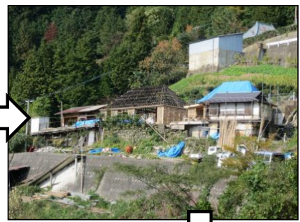
「新部家」施工状況
