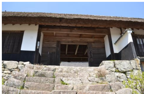
川人家長屋門の入口と石階段
