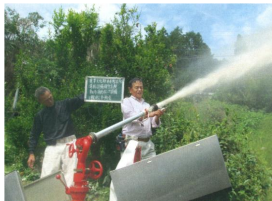
重要文化財木村家住宅での防災設備の保守点検 (実施日:H25. 9. 9)
