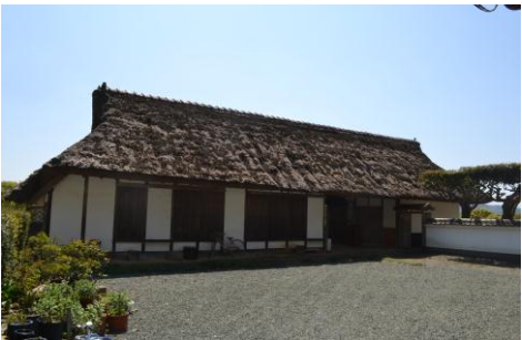
川人家長屋門の現況(背面)
