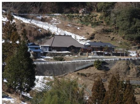
N邸 施工後
