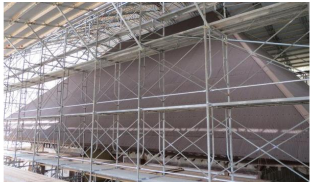
主屋 解体工事(着手前)
