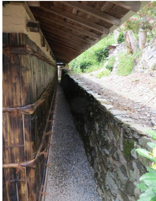
保存修理後(完了)
