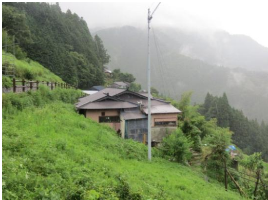
屋根塗り替え前
