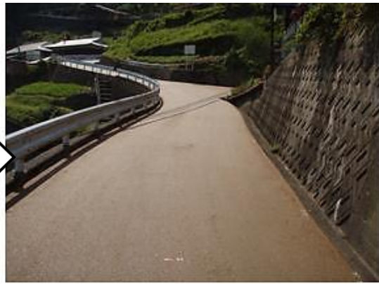
■道路美化(地道風舗装)後
