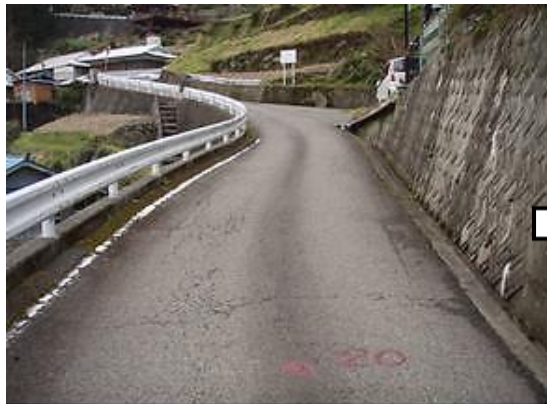
■道路美化(地道風舗装)前
