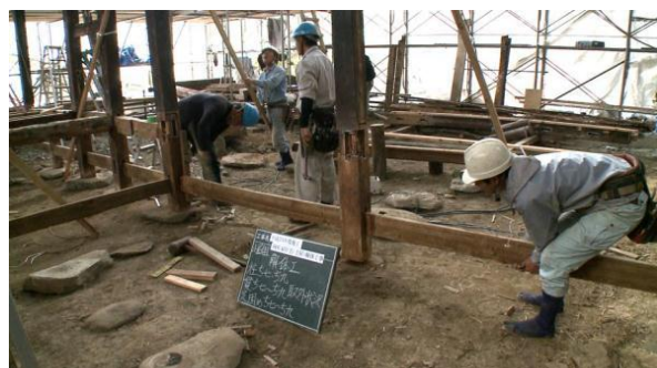
主屋 主要構造材解体状況
