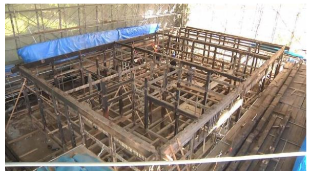
主屋 解体状況(主要構造材解体)
