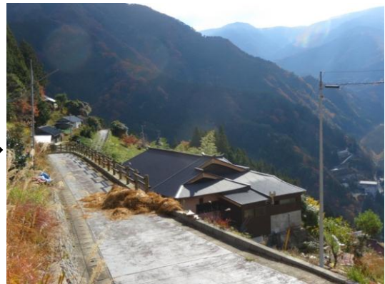
屋根塗り替え後(完了)
