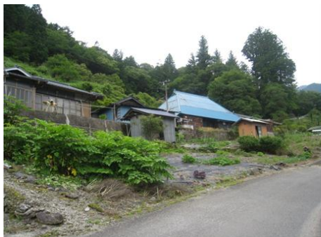
N邸 施工前
