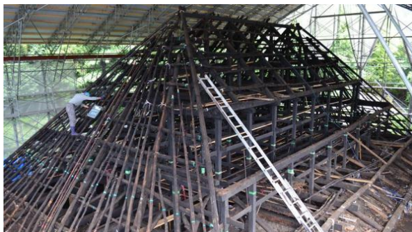
主屋 解体状況(屋根構造材解体)
