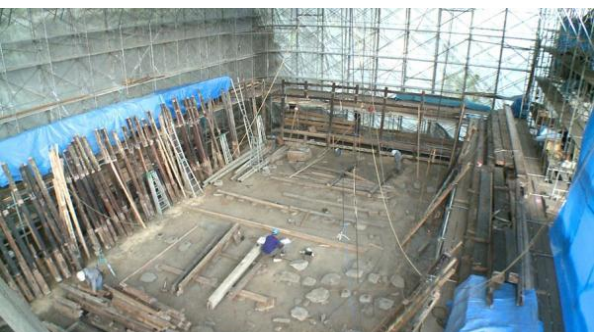
主屋 解体工事(完了)
