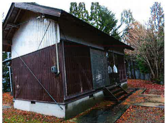
■拝殿(平成4年改修)内部一部古材が残る
