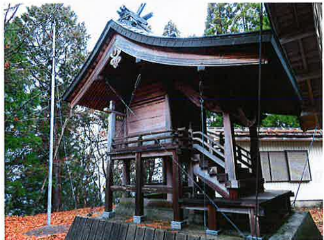
■天満宮本殿(昭和10年改修)
