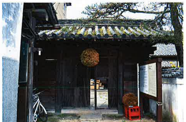
■武家門の軒先には、造り酒屋ならではの杉玉が吊られている
