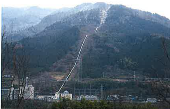
■松尾川発電所
