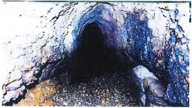
■三村用水トンネル
