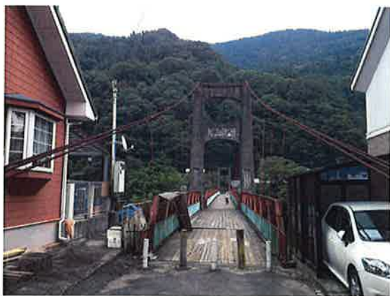
■「大川橋」昭和10年築
