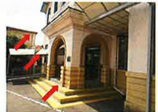
■上部のコーニスとアーチ型入口、腰壁
