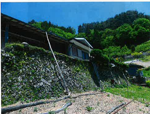
■民家を支える石垣
