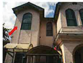
■1、2階上下の窓を囲うボーダー
