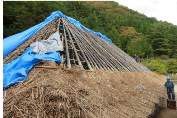
【屋根材へと生まれ変わった茅、観光施設「喜多家住宅」の屋根葺き替えに使われる。平成30年12月下旬】
