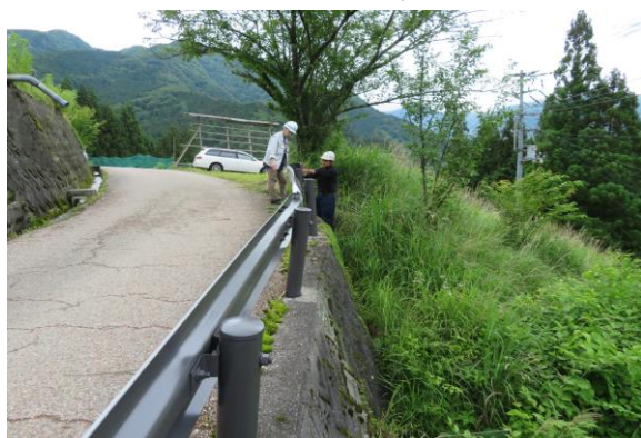
対岸からの景観および道路景観を良好にみせるための古色塗装されたガードレール
