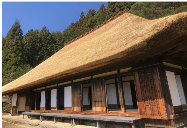
【「喜多家住宅」茅葺屋根葺き替え完工。平成31年3月】
