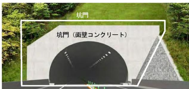
図 3 定期点検対象箇所（トンネル坑口部）
