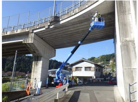
高所作業車による点検作業
