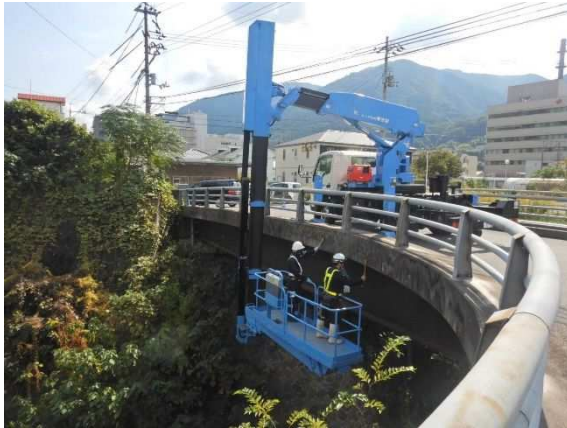
橋梁点検車による点検作業
