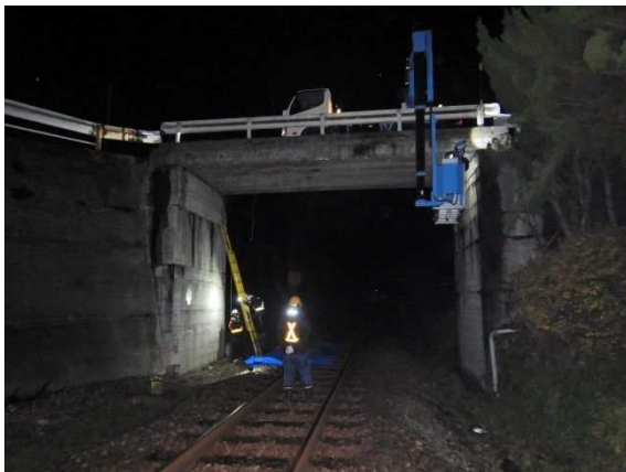
梯子、橋梁点検車による点検作業
