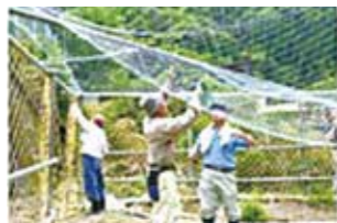
環境整備(防護ネット張り)
