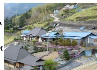
【屋根塗り替え前】
