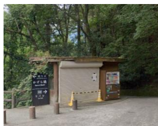
【景観阻害建造物】解体前
